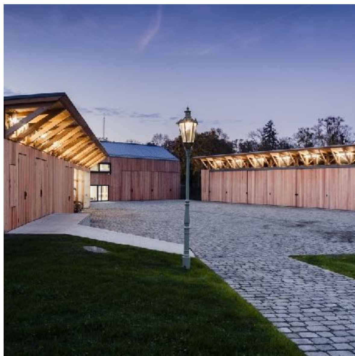
Национальный центр садовой культуры — Центр садоводства, Замок-сад в Кромержиже
